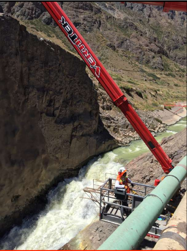
Trabajos sobre rio caudaloso.
