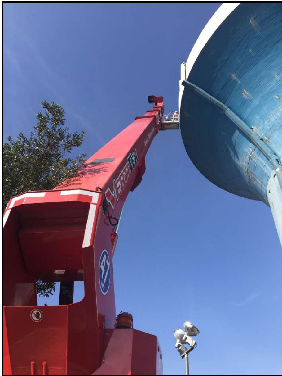
Inspección de copa de agua.
