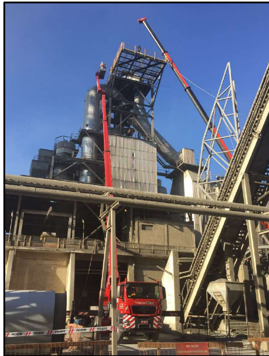
Instalación de estructura en planta MELON.
